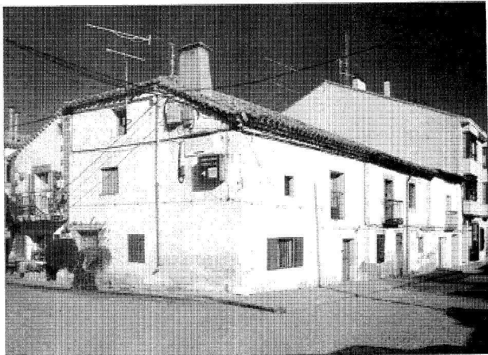
Vivienda en calle Real c/v Carmen, con un añadido posterior por la calle Fuente
