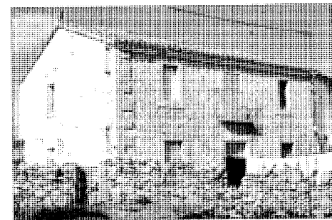
Las Navas de Buitrago. Vivienda en la calle de San Juan, 33.
