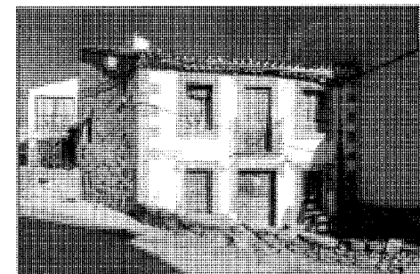
Gargantilla del Lozoya. Vivienda en la calle del Arroyo
