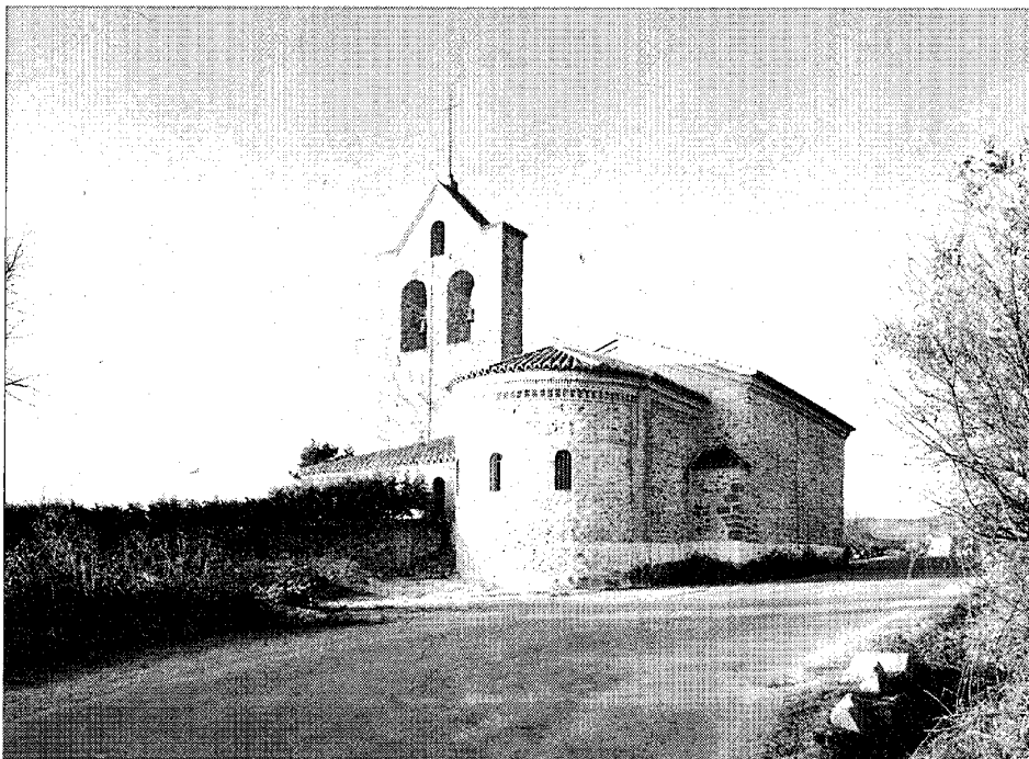
Vista general desde la cabecera
