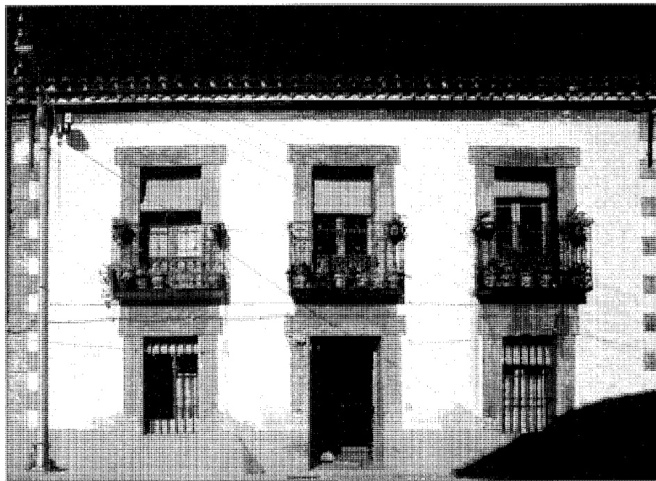
Vivienda en la calle del Generalísimo
