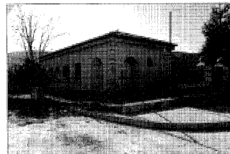
Escuelas en la calle del Puerto
