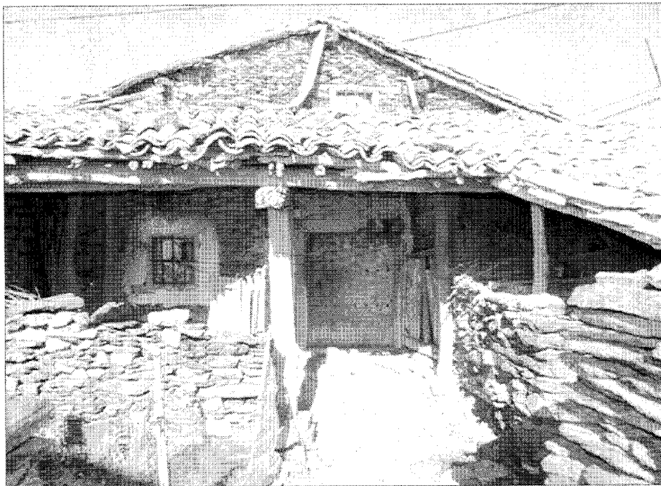
Vivienda en la calle del Olivo. Entrada
